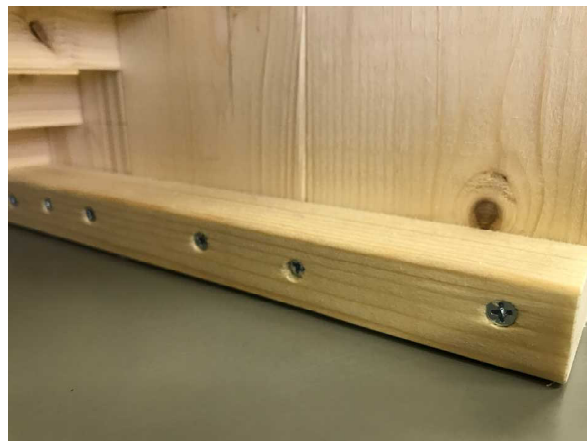
段をささえる木材を、底部ではねじ止めで固定します。
