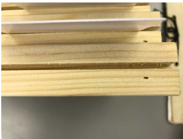
段の木材を、上部ではかくし釘で固定しています。
